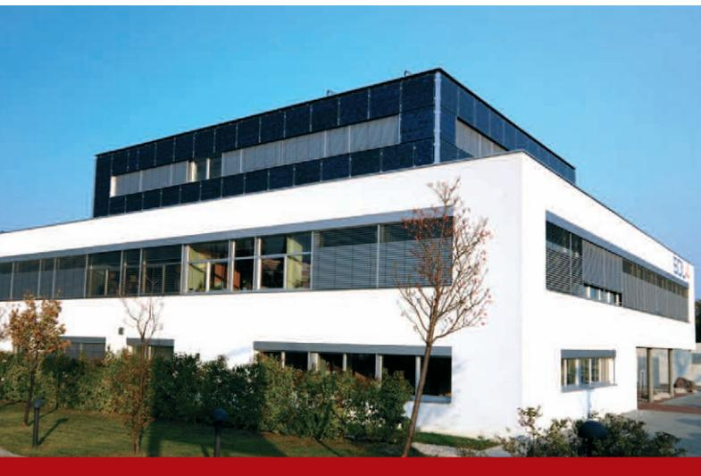
Besonders Wert gelegt wurde auf modernste Bau- und Haus-technik sowie ökologische Baumaterialien. Zum Einsatz kamen u.a. ein neuer, speicheroptimierter Ziegel, Lehm-Sichtziegel im Inneren des Gebäudes, umweltschonende Mineralschaumdämmplatten, zementfreier Beton (neuartiges Bindemittel statt Zement mit hohem CO<sub>2</sub> Einsparpotenzial), sowie ein neues „Clip-on“-Fassadensystem mit Strohdämmung und großzügiger Photovoltaik-Anlage an der Süd-, West- und Ost-Fassade.
