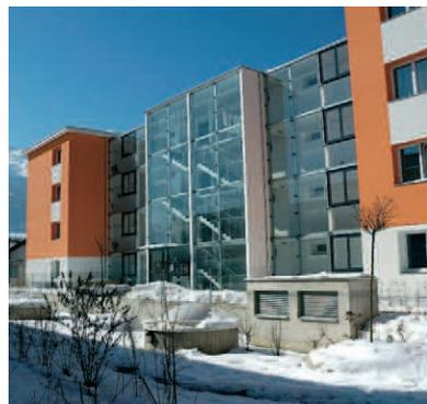
**Heizwärmebedarf**14,4 kWh/m<sup>2</sup>a BGF**Konstruktion**Außenputz, 12 cm Hochlochziegel (Vormauerschale), 22 (20) cm Mineralwolle
