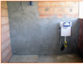
Verputz hinter der Vormauerung an der Außenwand im Sanitärbereich
