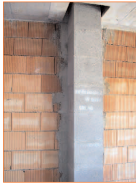
Verputz hinter dem Notkamin an der Außenwand
