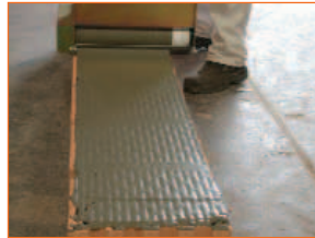
Planziegel mit VD Dünnbettmörtel und Walze
