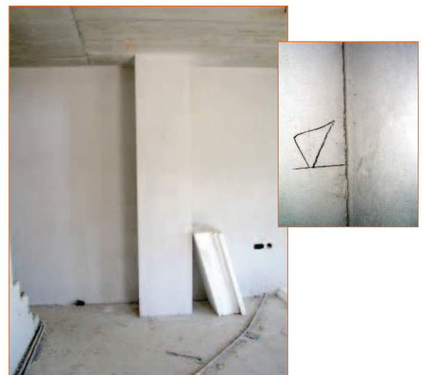
Abbildung 5: Verputzte Außenwand von Rohdeckenoberkante bis Rohdeckenuntergante inkl. gedämmtem und verputztem Notkamin, Kellenschnitt zwischen Kaminverputz und Außenwand (Acrylverfugung noch fehlend)
