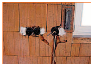
Abbildung 13: So sollte es nicht gemacht werden: Verteiler- und Steckdosen nur mit Mörtelbatzen fixiert, Installationschlitz nicht verfüllt
