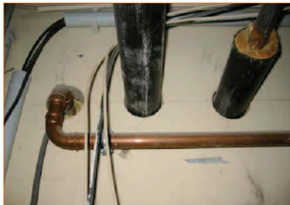
Abbildung 11: Solche getrennte Rohrdurchführungen kann man dicht bekommen
